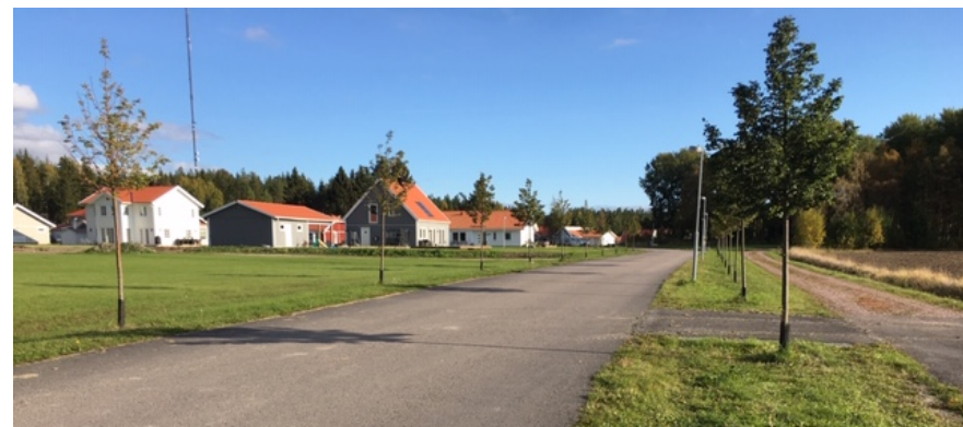
Figur 3. Infart till det befintliga småhusområdet Skästa Hage. Planförslaget är en fortsättning på småhusområdet och kommer att utformas med samma karaktär.
